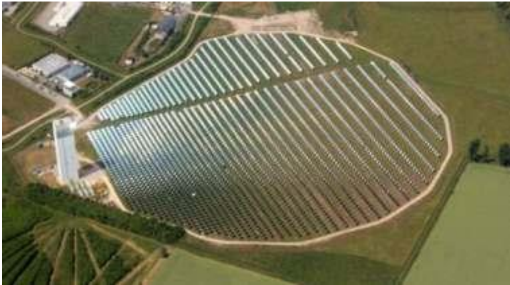
Σχήμα 30.3 Ηλιακός Συγκεντρωτικός Συλλέκτης με Κεντρικό Δέκτη επάνω σε Πύργο. Εγκατάσταση στο Jülich της Γερμανίας
