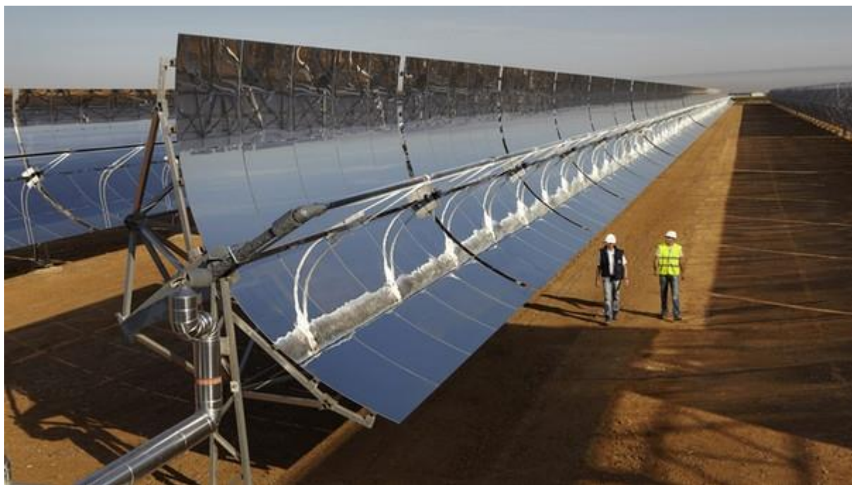
Σχήμα 30.2 Ηλιακός Συγκεντρωτικός Συλλέκτης με Σχήμα Παραβολικού Αυλακιού
